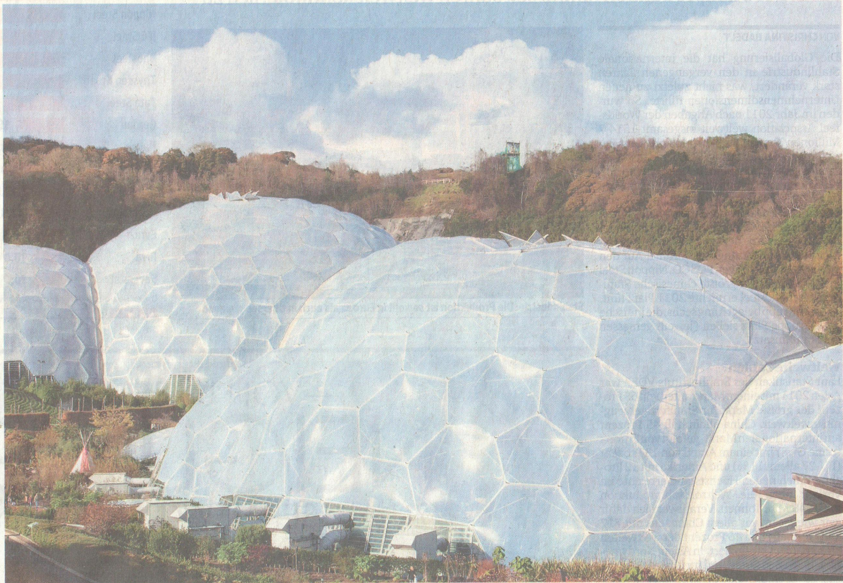
Eden Projekt, England: In der Stahlkonstruktion wurde ein Raumgerüst errichtet, das als größtes freistehendes Gerüst der Welt Eingang in das Guinness-Buch der Rekorde fand.
