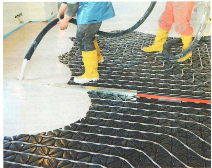
Die Wärmeverteilung im Oberhausener Wasserturm erfolgt mit dem Flächenheizsystem R 50 von Schütz – und passend zum jeweiligen Motto des Künstler-Domizils wurde in jedem Stock ein andersfarbiger Estrich verlegt.
