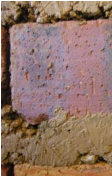
Abb. 147: Detail der Lehm-Ziegelwand
