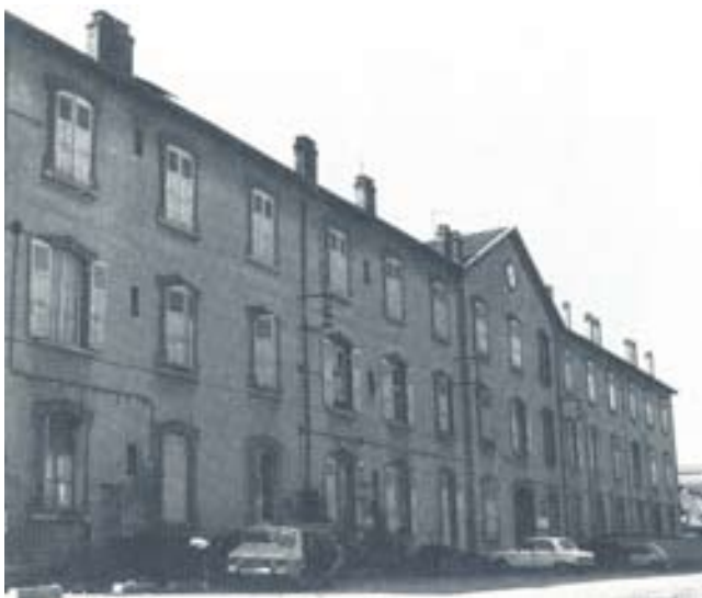
Abb.10: Gebäude aus Pisé, Saint- Siméon-De-Bressieux. Erbaut im Jahre 1882 als Arbeiterwohngen einer nahegelegenen Fabrik. Die Einflüssen Cointeraux's sind gut ablesbar.
