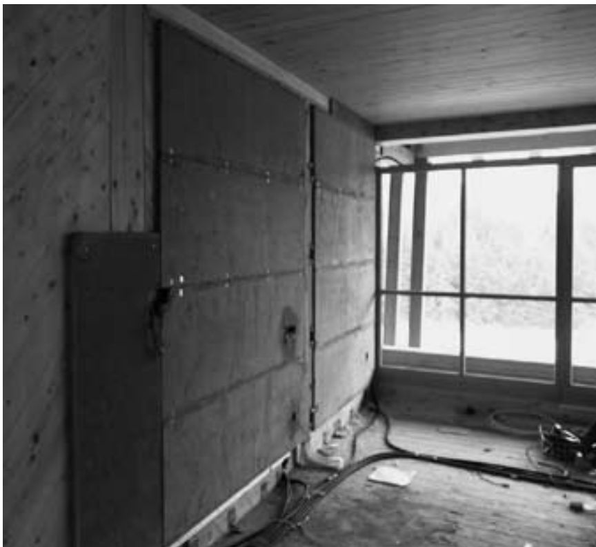
Abb. 215: Einbau von Wandheizungselementen aus Lehm
