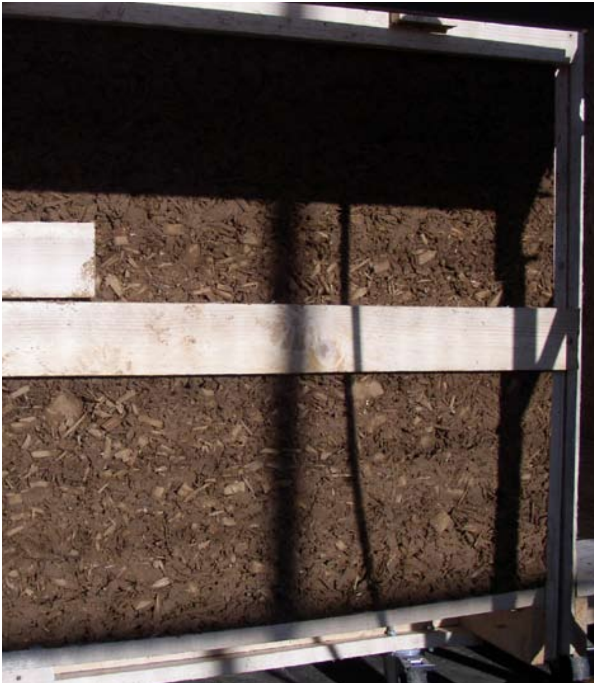
Abb. 168: Holzleichteilwand unmittelbar nach entfernen der Schalung
