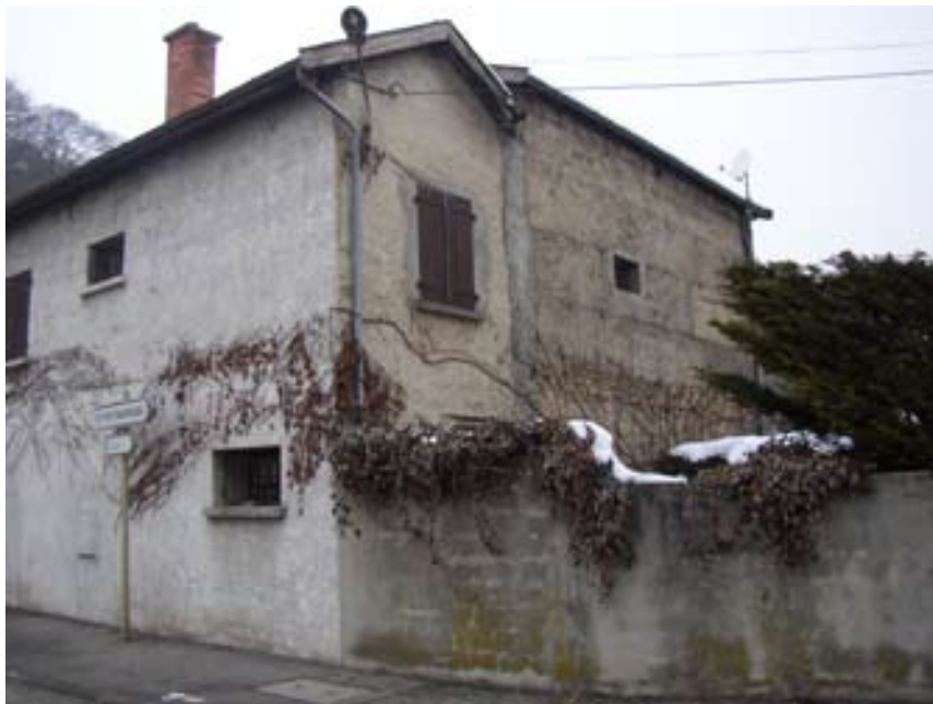
Abb. 193: Gebäudeteil in Pisébauweise
