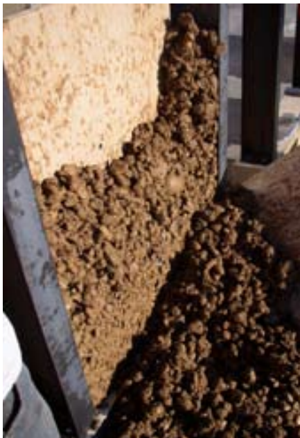
Abb. 125: Abnehmen der Schaltafel
