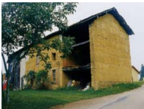
Abb. 48: Bauernhof aus Pisé (La Charpenay, Isère)
