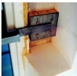
Bild 8: Befestigung des Fenstergeländers in wärmebrückenreduzierter Ausführung
