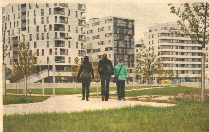
Die dann fertig sanierte Werkbundsiedlung (Bild oben) wird im Rahmen der IBA ebenso hergezeigt wie die Seestadt Aspern.
